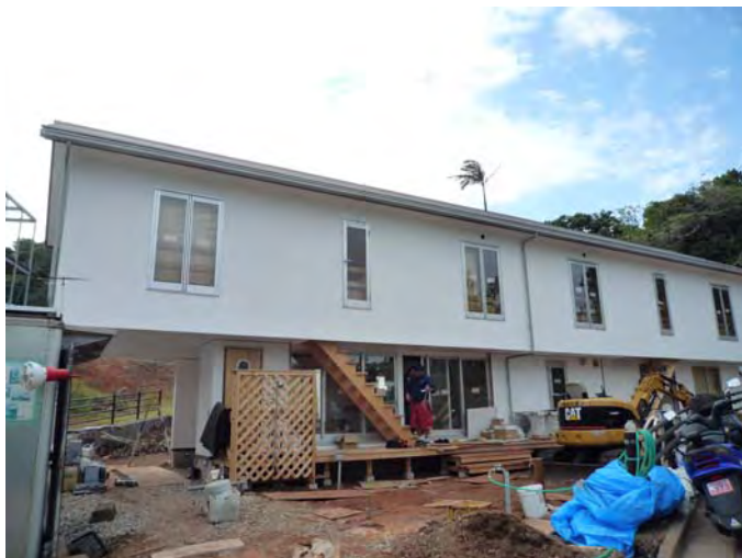
アプローチ 貫通通路とメインダイニング
