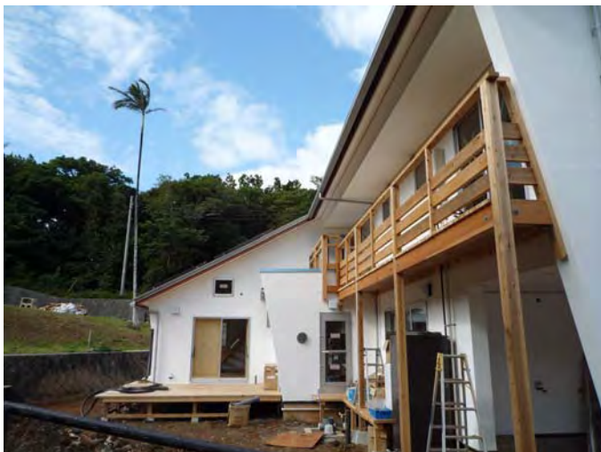
南東隅から見上げ
