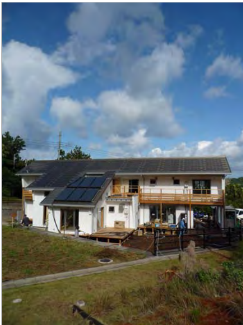
南側全景 太陽光発電5kW ソーラー給湯
