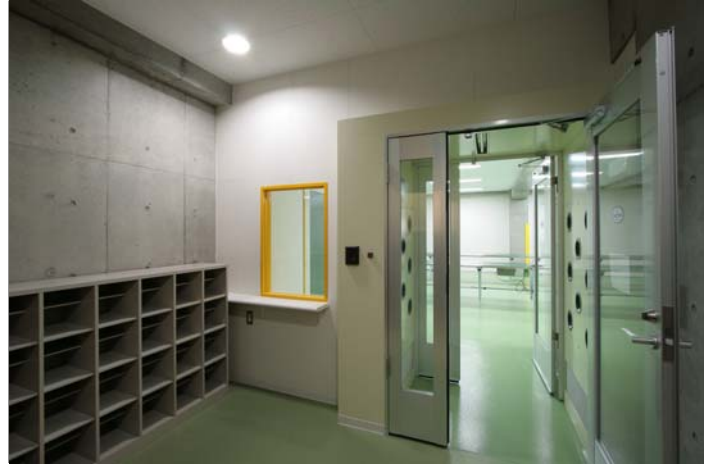
IMG_6530.JPG 8. 2階昇降口 (エアシャワー)
