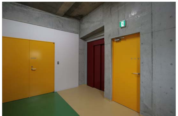
IMG_6527.JPG 12. 3階エレベーターホール
