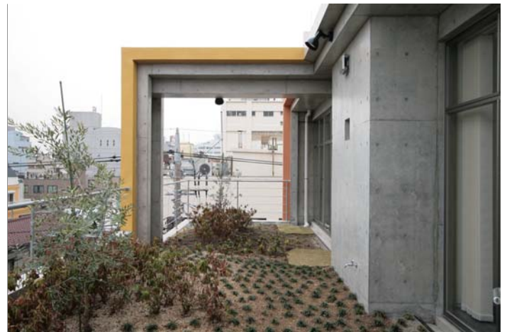
IMG_6383.JPG 28. 南側の屋上緑化を見る
