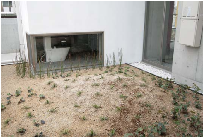
IMG_6370.JPG 27. 屋上緑化越しのトイレ
